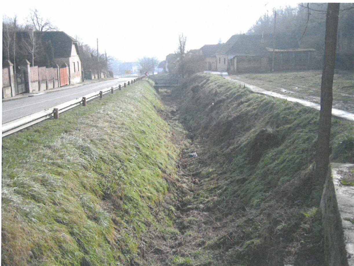
Slika 1: Kanal nizvodno od cestovnog propusta
