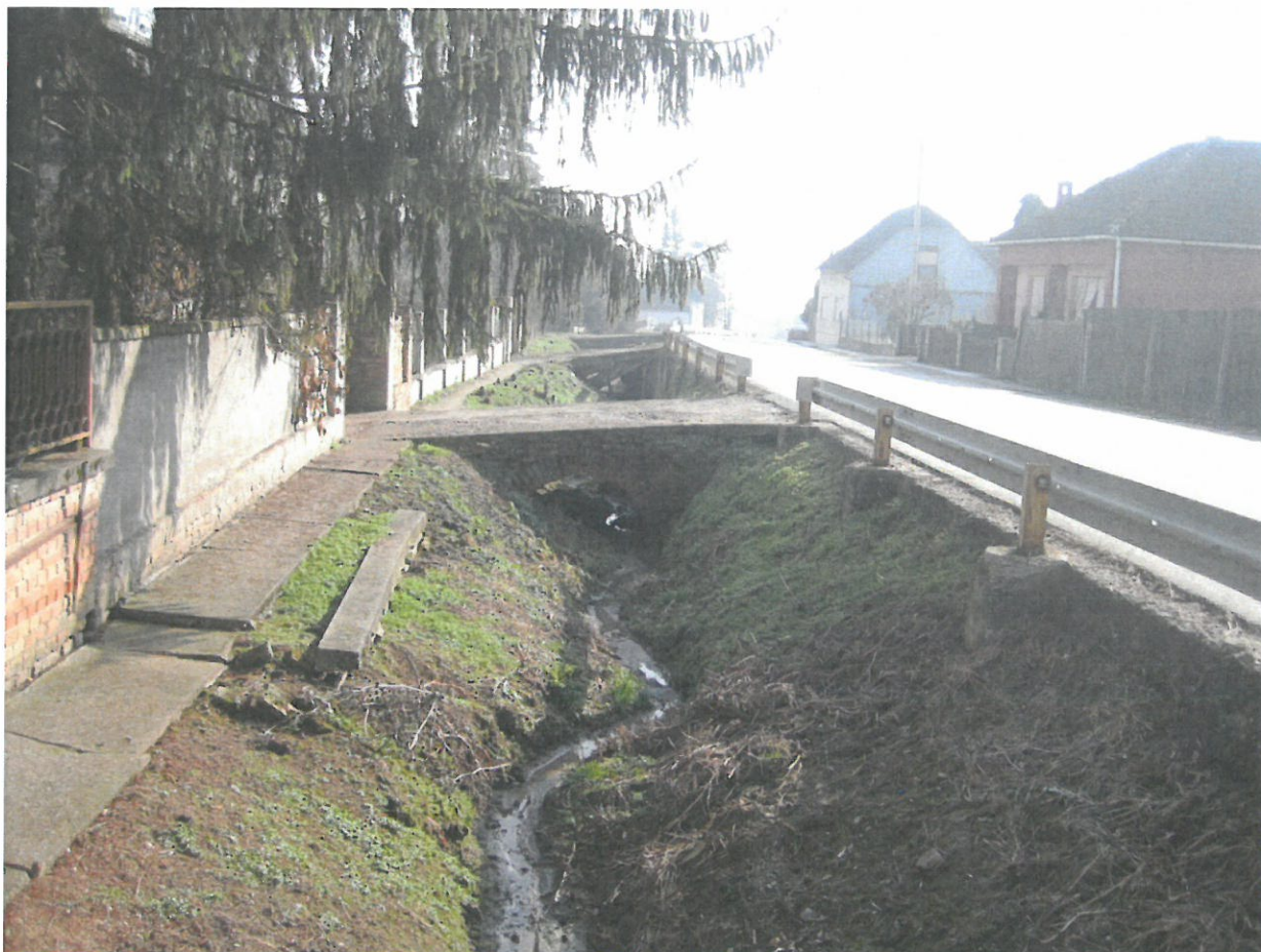
Slika 2: Kanal uzvodno od cestovnog propusta
